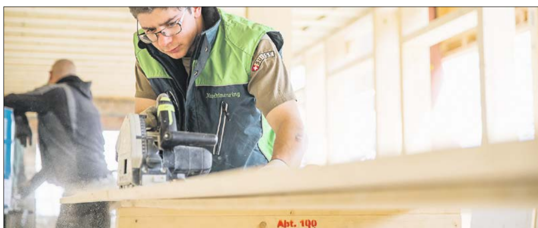
Mitarbeiter des Maschinenrings bei Zimmermanns-Arbeiten.
