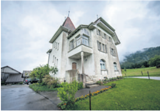
La maison de Christine Bühler, bâtie en 1919, semble sortir d'un film de Hitchcock!
